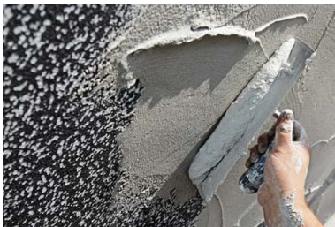
1 Schicht Armierungsmörtel
