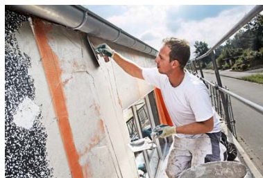
Armierungsgewebe einbetten
