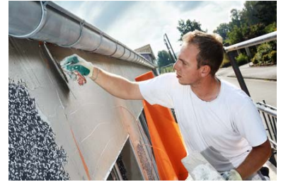
2 Schicht Armierungsmörtel
