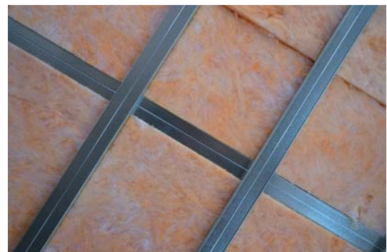
Dämmung über den CD- Profilen
