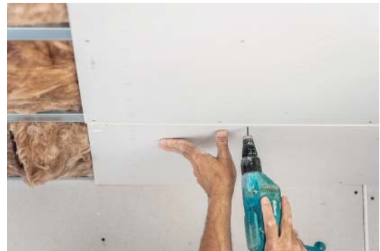
gedämmte abgehängte Decke - Befestigung der Gipskartonplatten
