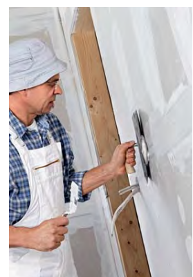
Verspachteln der Fugen
