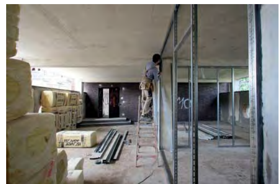
Montage Trennwand mit Metallprofilen
