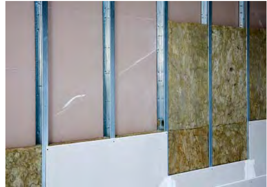
Aufbau einer Trennwand mit Metallprofilen
