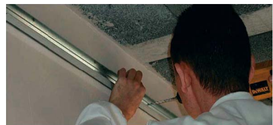
Befestigung der umlaufenden Rahmenprofile (UD- Profile)
