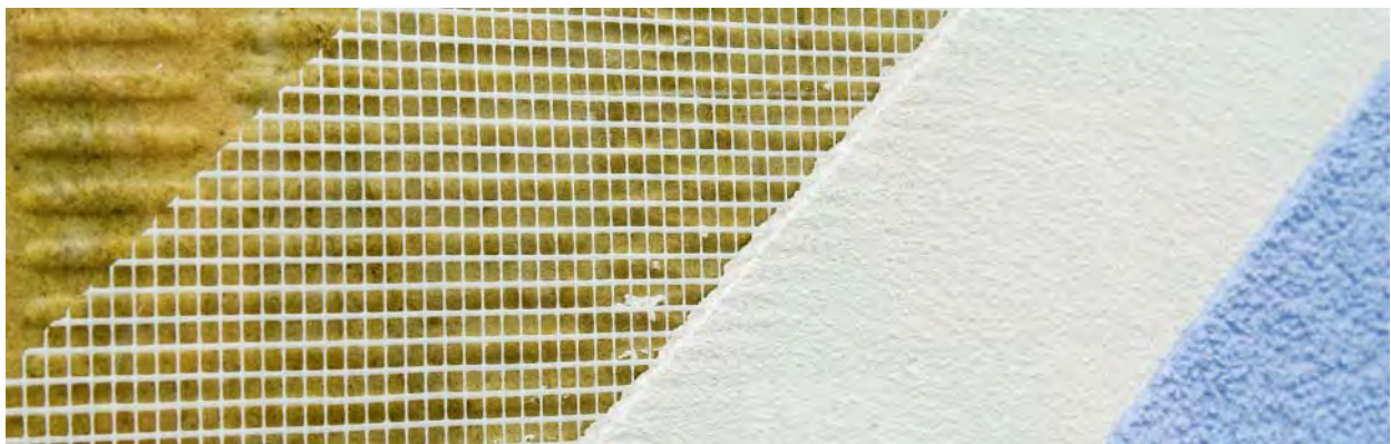
Aufbau einer Fassadendämmung mit mineralischen Dämmplatten aus Steinwolle
