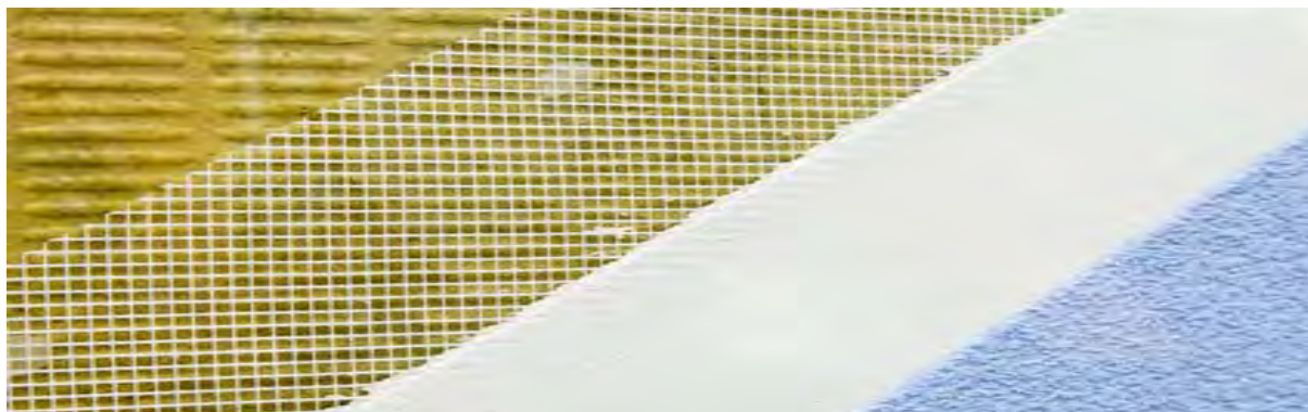
Aufbau einer Fassadendämmung
