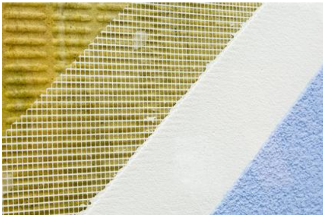
Aufbau einer Fassadendämmung
